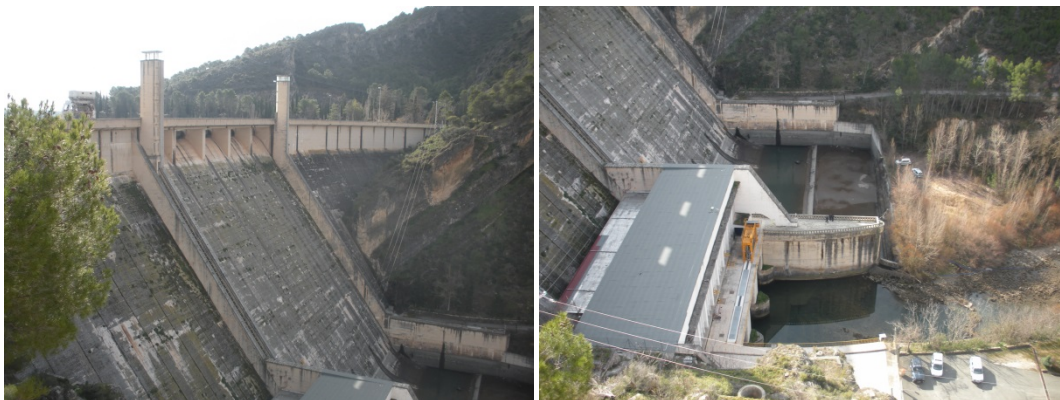
Figura 1 | Presa de Buendía. Aliviadero y cuenco amortiguador junto a central hidroeléctrica
