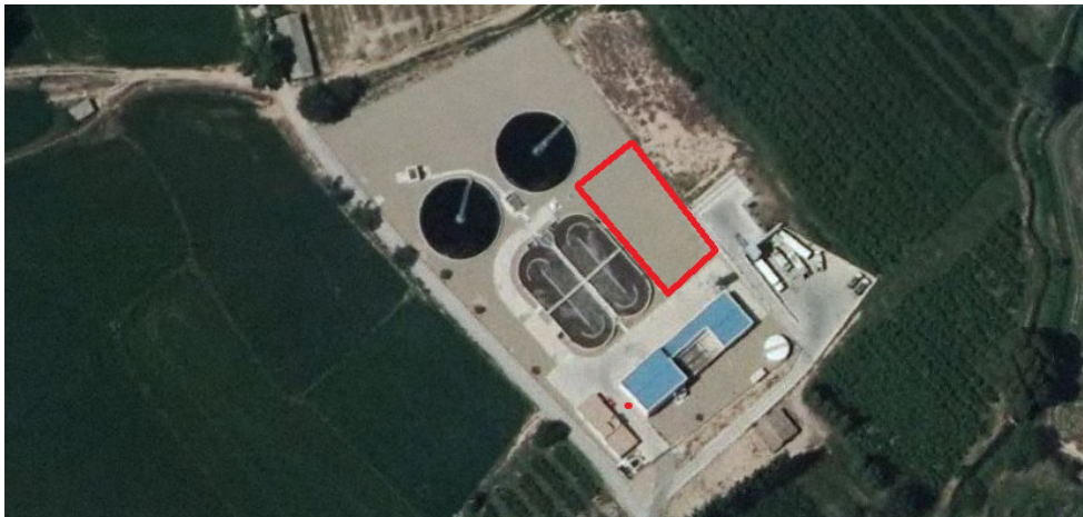
Figura 1 | Ubicación de la planta piloto en la EDAR de La Almunia de Doña Godina.
