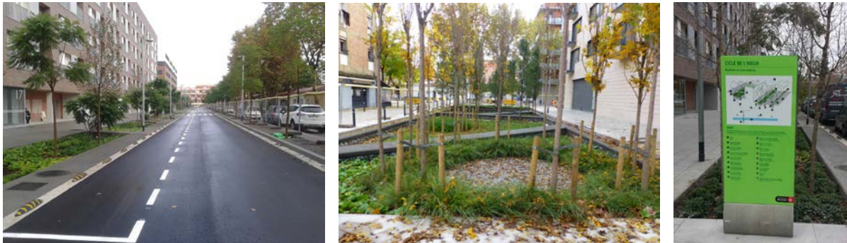
Figura 1 | Franja de biorretención (izquierda), parterre inundable (centro) y cartel informativo (derecha) en el barrio de Bon Pastor (Barcelona).
