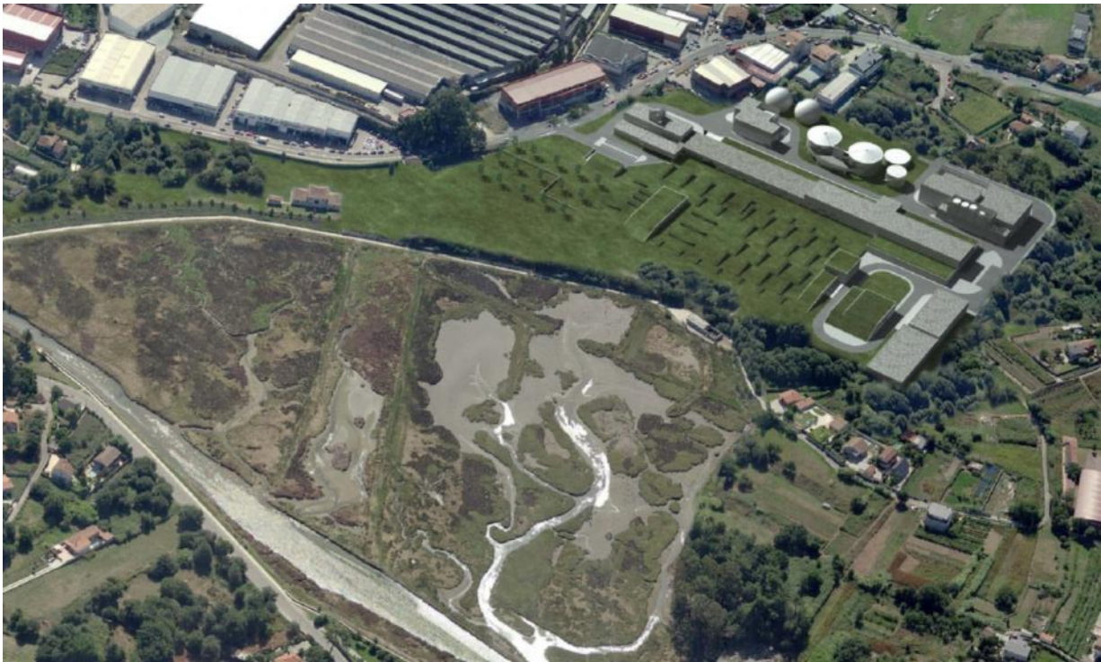
Figura 1 | Vista general de las instalaciones de la nueva EDAR de Lagares e integración en el entorno natural de la marisma del río Lagares.
