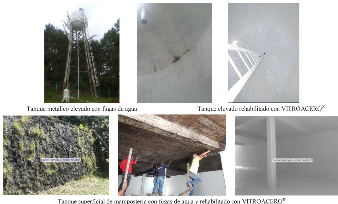
Figura 7 | Rehabilitación con VITROACERO® de 3 tanques de almacenamiento / distribución de agua potable (antes y después).
