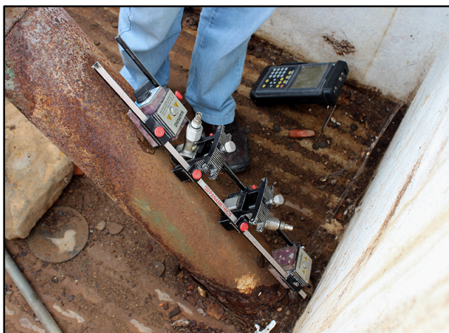
Figura 3 | Instalación del medidor de caudal para realizar la toma de datos
