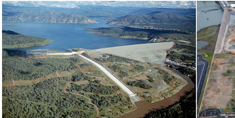
Figura 10 | Presa de Oroville. Izquierda: vista general desde aguas abajo. Se aprecian cuerpo de presa, aliviadero principal con canal de descarga y aliviadero de emergencia. Derecha: detalle del aliviadero de emergencia. Se aprecia en la zona superior el tramo con perfil hidrodinámico y en la inferior el muro. Fuente: DWR, 2017a
