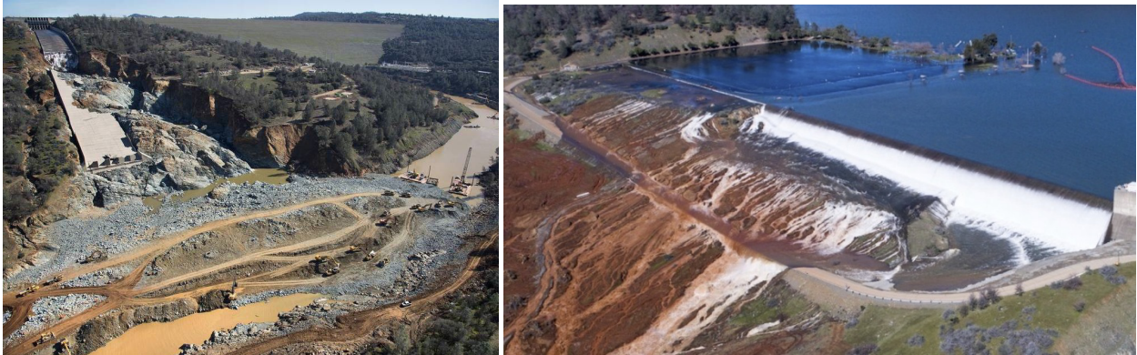
Figura 11 | Presa de Oroville, consecuencias de la crisis de 2017. Izquierda: estado final del canal de descarga del aliviadero principal y del cauce. Derecha: erosión generalizada en la ladera de aguas abajo del aliviadero de emergencia. Fuente: DWR, 2017a
