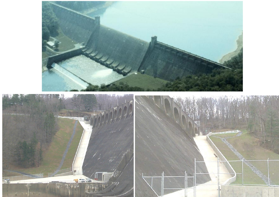
Figura 1 | Presa de Tygart (Virginia Occidental, EE.UU.). Superior: vista general de la presa previa a la construcción de la protección. Inferior: detalle de los cajeros construidos como sistema de protección ante el descalce. Fuente: Zaitsoff, 2013
