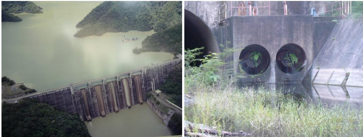
**Figura 1** | A la izquierda, Presa de Valdesia. A la derecha, válvulas Howell-Bunger de desagües de fondo de la presa de Bao.
