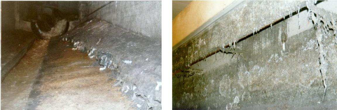
Figura 3 Suciedad acumulado en la solera (izquierda) y en las pantallas antiflotantes (derecha) de la cámara en línea de un depósito de retención-aliviadero
