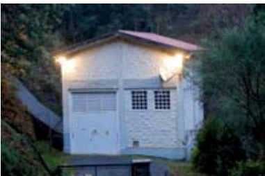
Central hidroeléctrica Barreiros (Aranga)
