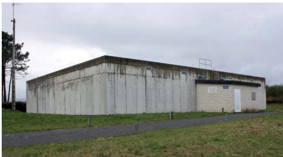
Depósito da Ratona (Curtis)
