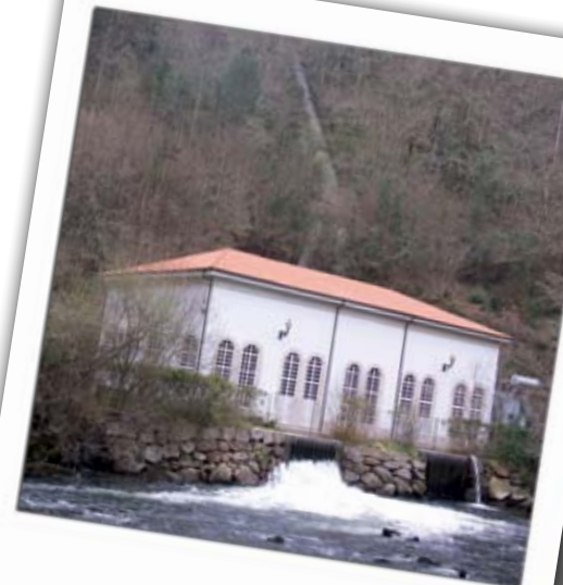
Central hidroeléctrica Mandeo-Zarzo
