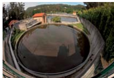
EDAR de Coirós
