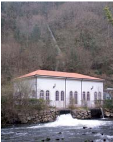
Central hidroeléctrica Mandeo-Zarzo (Paderne)
