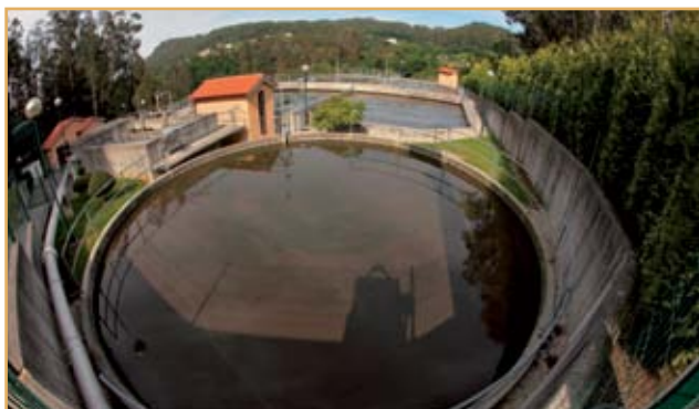
EDAR de Coirós
