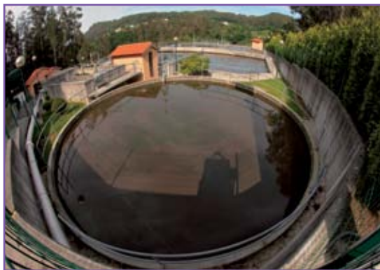
EDAR de Coirós
