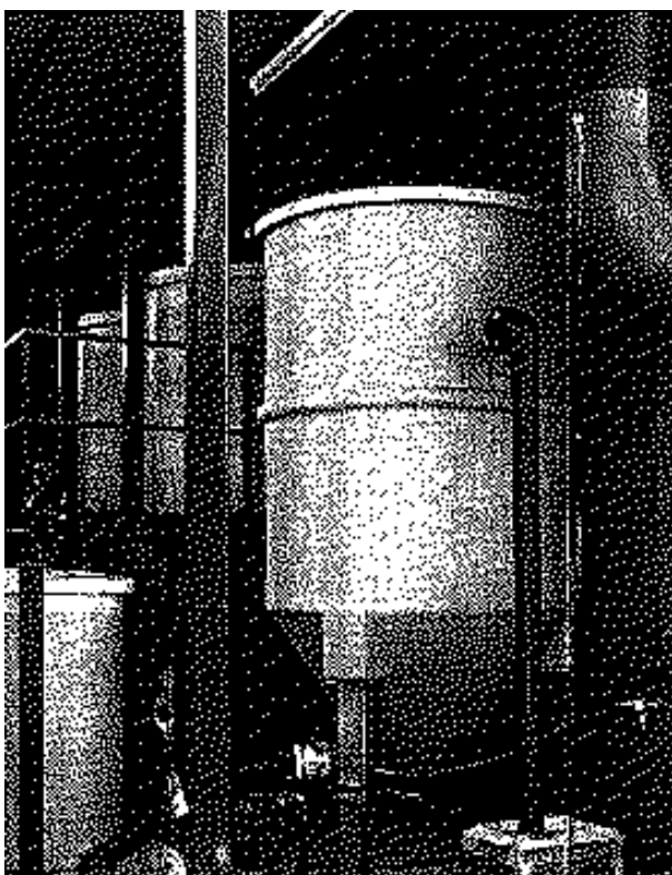
Sistema de dosificación.
