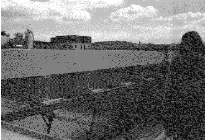
Decantador rectangular con puente de rasquetas
