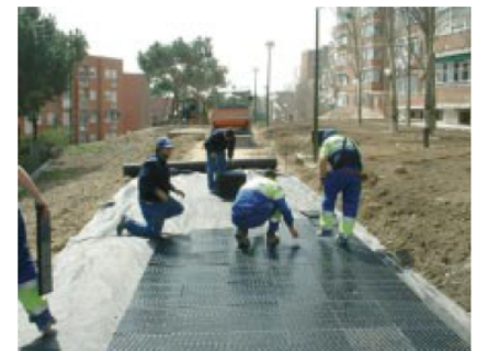
Instalación de pavimentos. Gravilla
