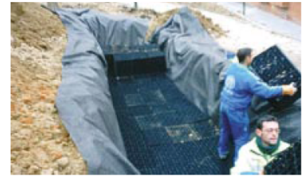
Instalación de depósitos
